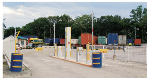
ITを活用した車両入退場管理システムを導入し、コンテナ輸送を管理している。24時間利用できるよう夜間照明も設置
