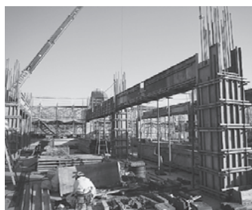
型枠工事の建設現場
