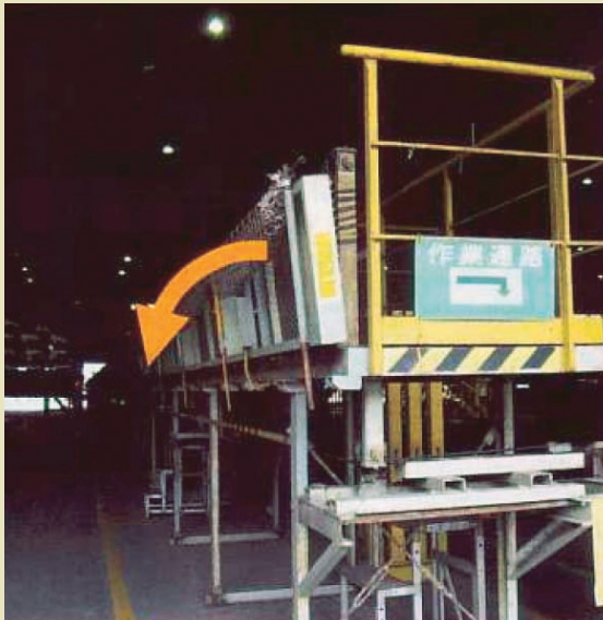
作業床を使用する前
