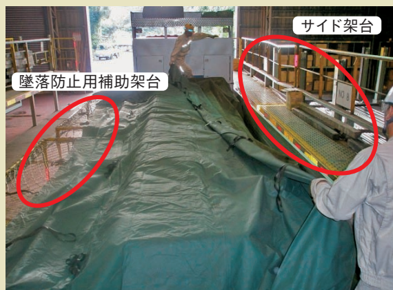
シート掛け作業風景
